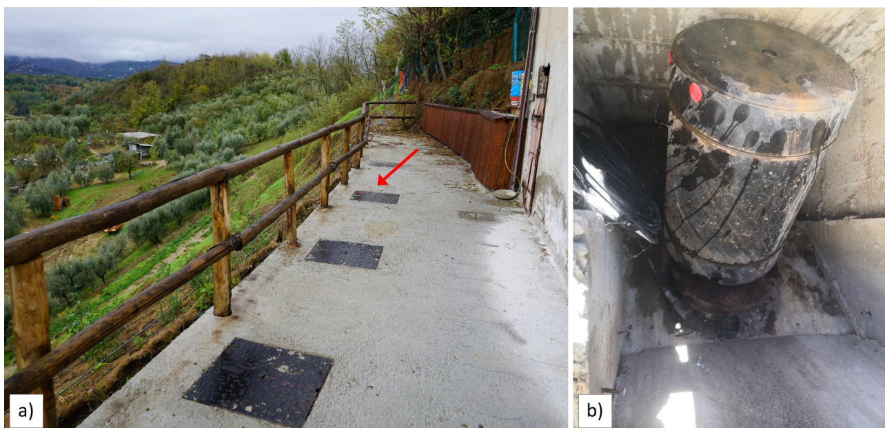
Figura 9 - Vista del cordolo di testa di una delle berlinesi tirantate sul versante S; la freccia di colore rosso indica il pozzetto di installazione della cella di carico; b) cella di carico.
